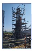
Puente peatonal Ducales: Se llevaron a cabo actividades de traslado de maquinaria, armado de aceros de refuerzo de canastas para pilotes, excavación para pilotes y fundida de columnas.
