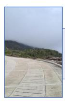
El ICCU a través del Plan 500 atendió los puntos críticos de 7 tramos en el corredor Quetame - Calvario (Meta). En el tramo 1 se culminó la construcción de 400 metas de placa huella y en el tramo 2 se continuó con actividades de conformación y compactación.
