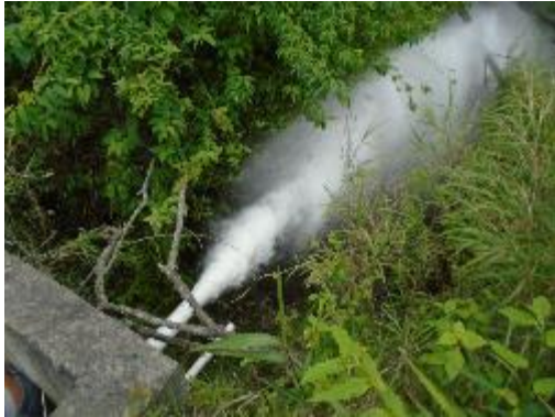
Fotografía 45. Válvula de purga 1 (Conducción)
