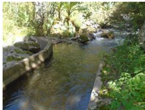
Fotografía 2. Vista Frontal de Bocatoma encausamiento
