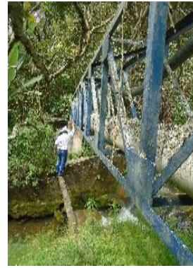
Fotografía 52. Paso elevado, Aducción
