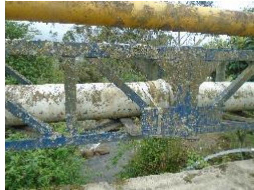
Fotografía 64. Paso elevado (Después de la Ventosa 1)
