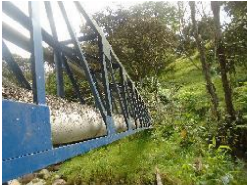
Fotografía 53. Paso elevado, Aducción
