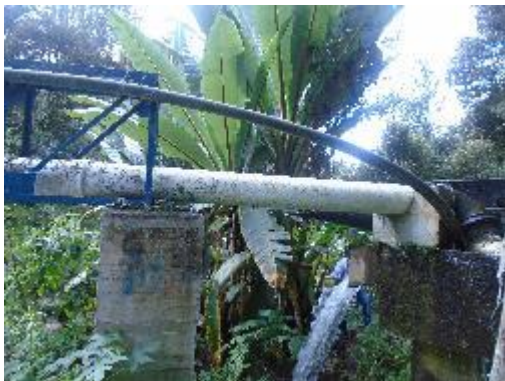
Fotografía 55. Paso elevado, Aducción
