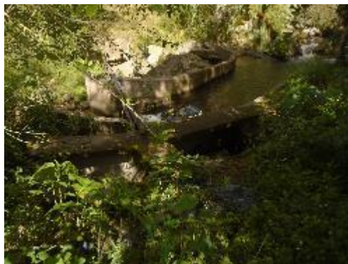
Fotografía 12. Vista Frontal de Bocatoma
