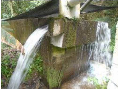
Fotografía 13. Desarenador Excesos
