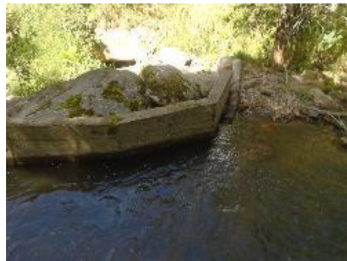
Fotografía 8. Vista Frontal de Bocatoma
