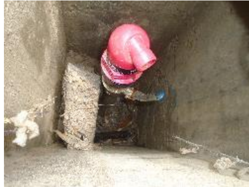
Fotografía 34. Vista Válvula de Aire
