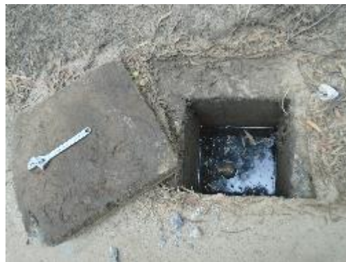
Fotografía 34. Vista Válvula de Aire
