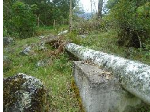
Fotografía 58. Paso elevado, Conducción
