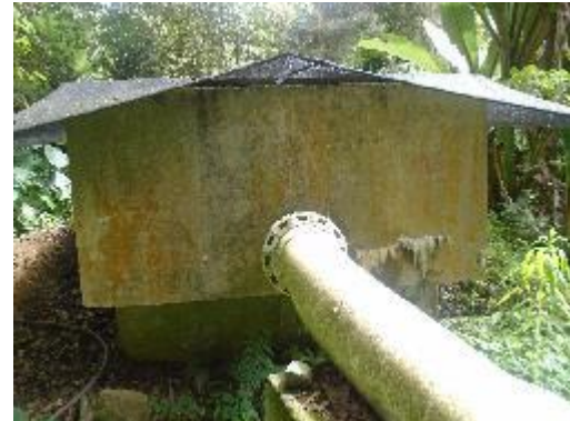
Fotografía 22. Salida de desarenador
