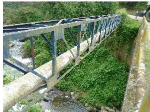
Fotografía 62. Paso elevado, Conducción
