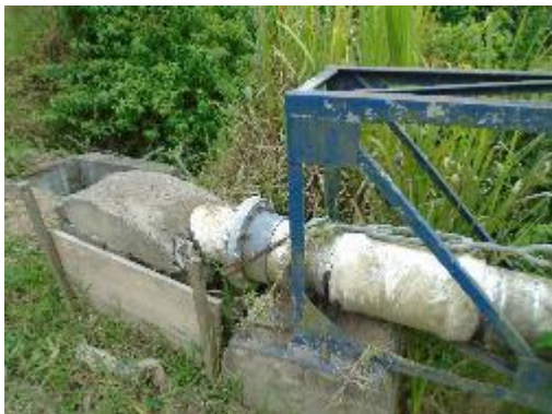
Fotografía 61. Paso elevado, Conducción
