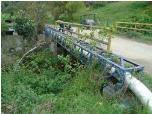
Fotografía 65. Paso elevado (Después de la Ventosa 1)
