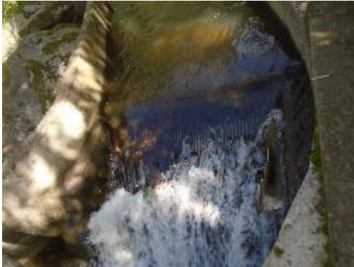
Fotografía 3. Vista Frontal de Bocatoma
