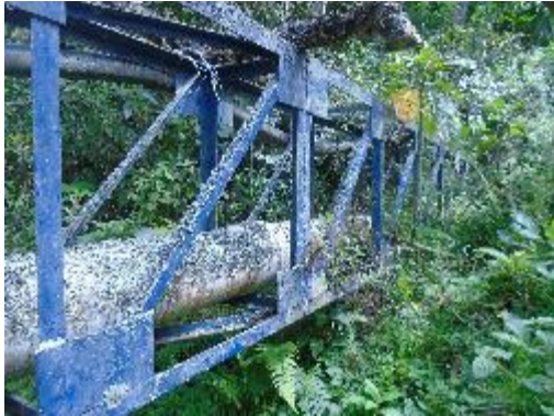
Fotografía 51. Paso elevado, Aducción
