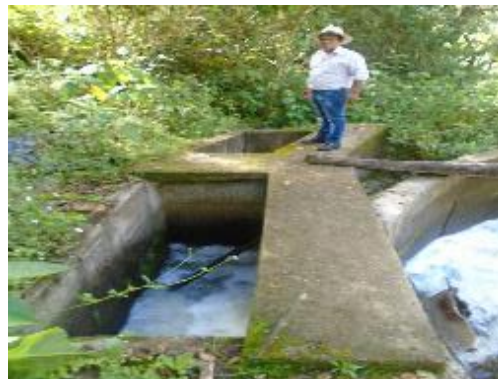
Fotografía 10. Vista Frontal de Bocatoma
