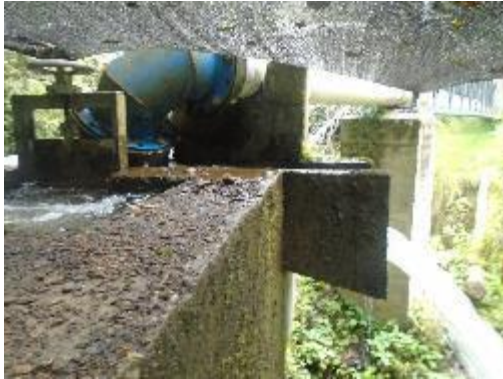
Fotografía 19. Desarenador rebose
