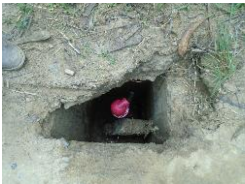
Fotografía 33. Vista Válvula de Aire
