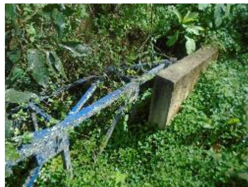
Fotografía 50. Paso elevado, Aducción
