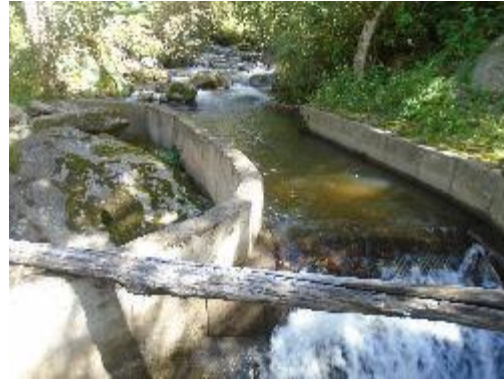
Fotografía 4. Vista Frontal de Bocatoma
