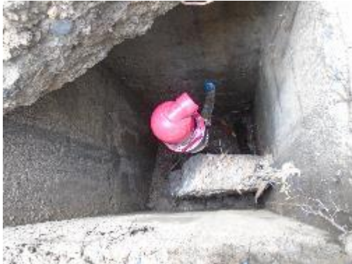
Fotografía 33. Vista Válvula de Aire
