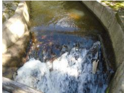
Fotografía 6. Vista Frontal de Bocatoma
