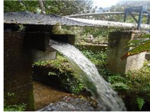
Fotografía 20. Desarenador rebose
