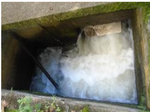
Fotografía 11. Vista Frontal de Bocatoma
