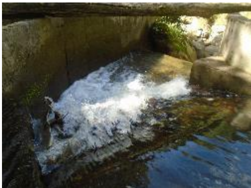
Fotografía 9. Vista Frontal de Bocatoma
