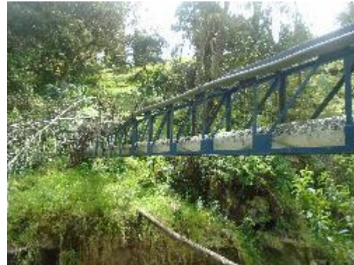
Fotografía 54. Paso elevado, Aducción
