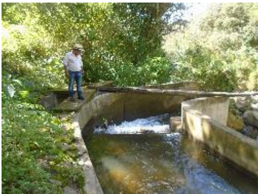
Fotografía 7. Vista Frontal de Bocatoma
