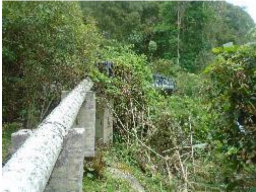
Fotografía 57. Paso elevado, Conducción
