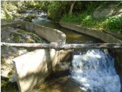
Fotografía 5. Vista Frontal de Bocatoma
