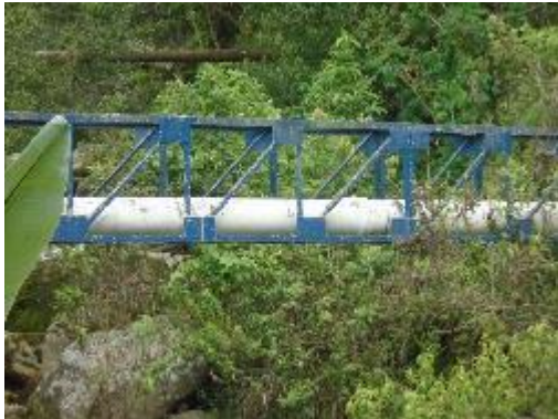
Fotografía 59. Paso elevado, Conducción
