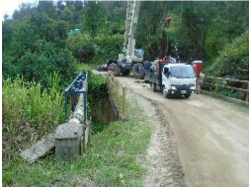
Fotografía 63. Paso elevado, Conducción
