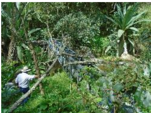
Fotografía 49. Paso elevado, Aducción
