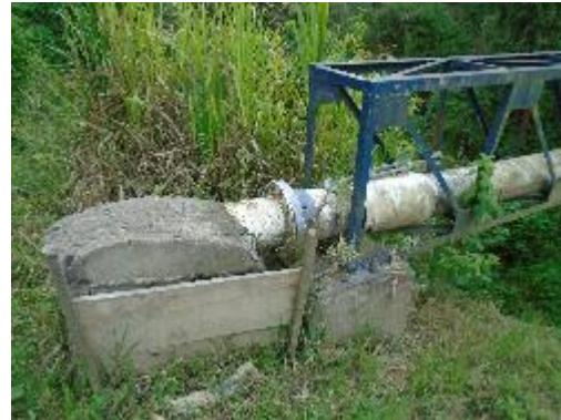
Fotografía 60. Paso elevado, Conducción
