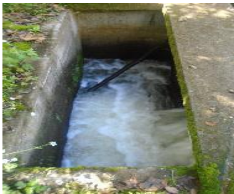
Fotografía 1. Vista Frontal de Bocatoma- caja de derivación
