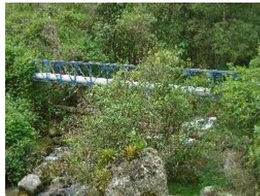
Fotografía 56. Paso elevado, Conducción
