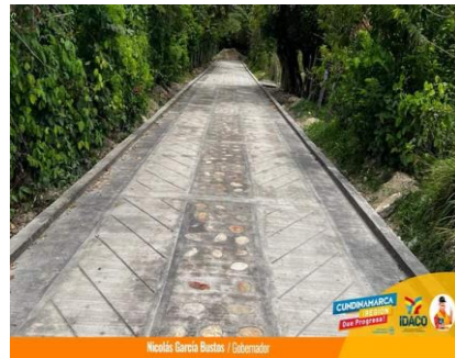
Después de la construcción de la placa huella en la Junta de Acción Comunal de la vereda San Lorenzo en Girardot.
