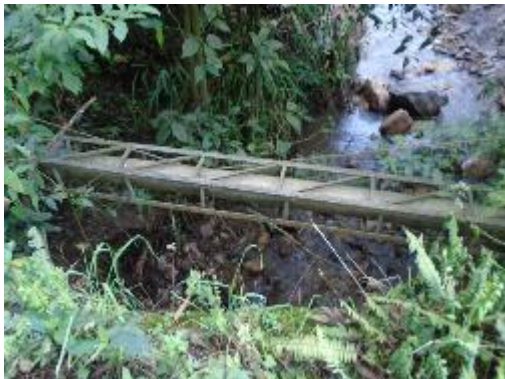
Fotografía 22. Paso elevado 2, Después del usuario 1
