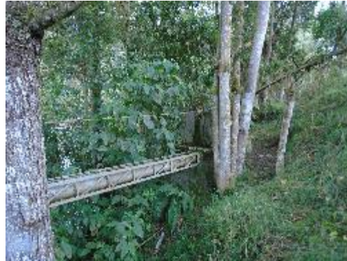
Fotografía 21. Después del desarenador
