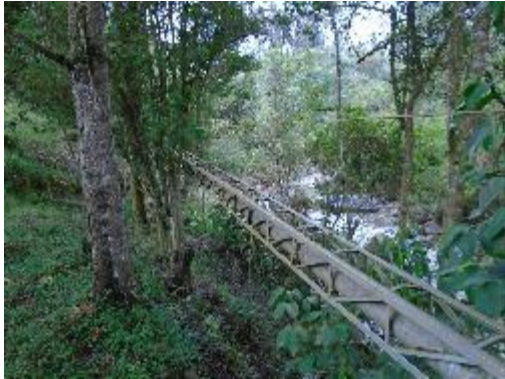
Fotografía 20. Paso elevado Después del desarenador
