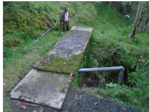
Fotografía 7. Vista Frontal del Desarenador
