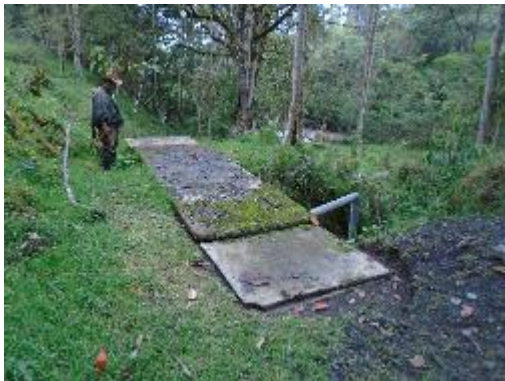
Fotografía 6. Vista Frontal del Desarenador
