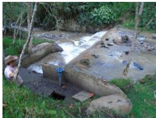
Fotografía 4. Vista lateral de Bocatoma
