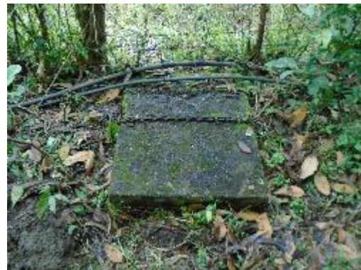
Fotografía 13. Vista Válvula de Aire
