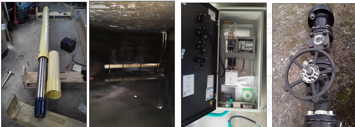
Ilustración Rehabilitación sistema de bombeo acueducto San Bartolome.
