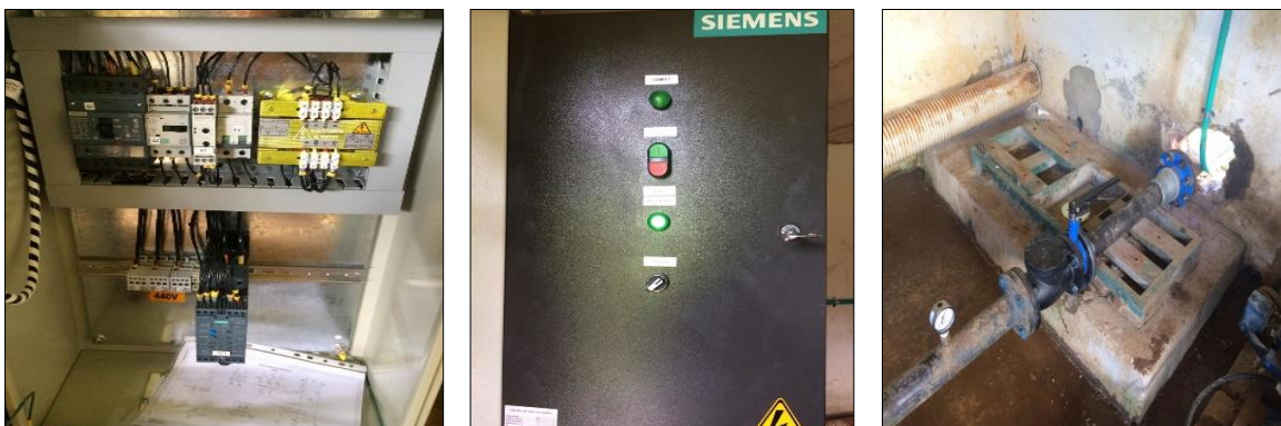
ustración 10. Rehabilitación sistema de bombeo acueducto El Termal.
