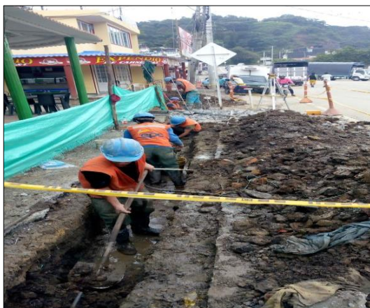
Ilustración 7 Rehabilitación con ramming red de alcantarillado la Gran Vía en el municipio de Tenjo
