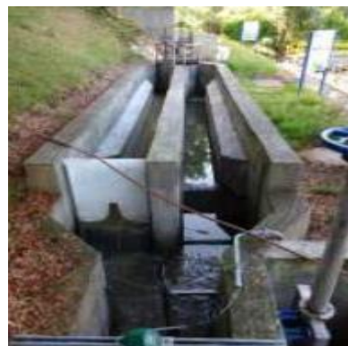
Ilustración -Vista de la estructura de cribado y desarenado de las aguas residuales a la entrada del sistema de agua residual doméstica de Guatavita
