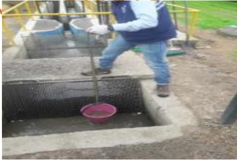
Ilustración Toma de muestra horaria en la entrada de la PTAR La Calera, se observa la canaleta parshall, donde se realiza la medición de caudal.
