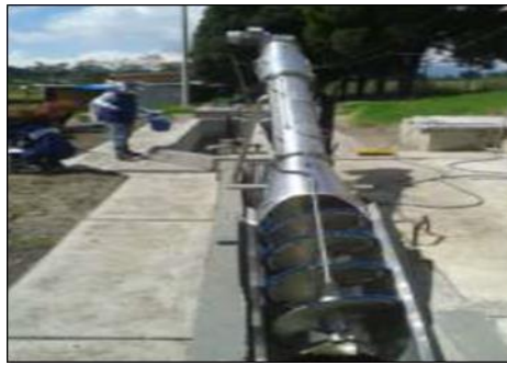
Ilustración - Tornillo sinfín a la entrada del sistema de tratamiento de aguas residuales de El Rosal.
