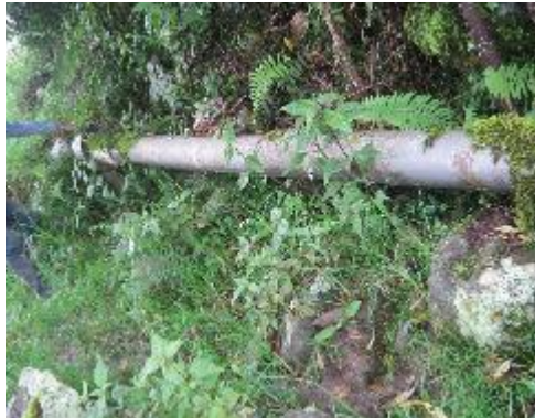
Fotografía 16. Tubería Anclada sobre nivel del suelo.
