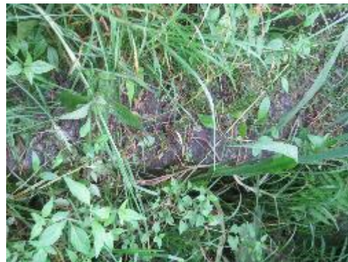
Fotografía 6. Tramo de tubería encofrado
