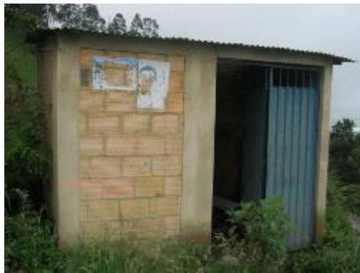
Fotografía 27. Estación de filtrado.
