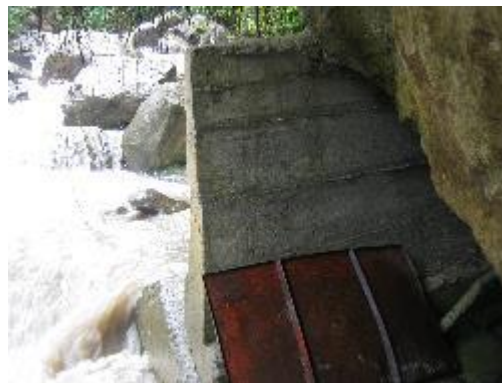
Fotografía 2. Muro protector de la bocatoma
