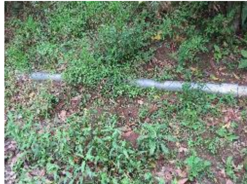
Fotografía 17. Tubería a Nivel del Suelo
