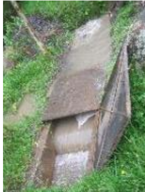
Fotografía 11. Vista Frontal Desarenador
