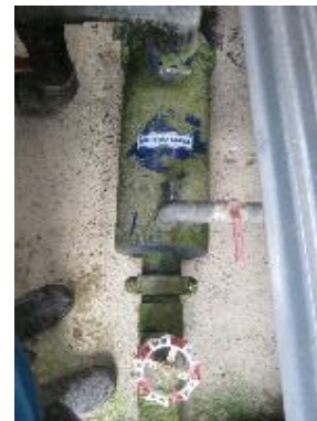
Fotografía 30. Filtros de Malla.
