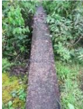
Fotografía 7. Tramo de tubería encofrado
