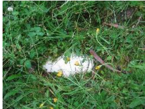
Fotografía 8. Tubería a Nivel de Terreno
