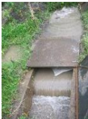
Fotografía 9. Vista Frontal Desarenador
