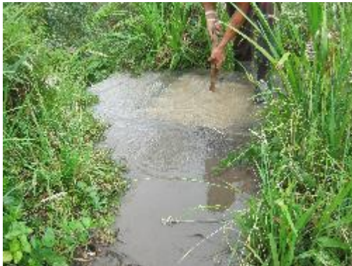
Fotografía 24. Cámara de Quiebre 4”
