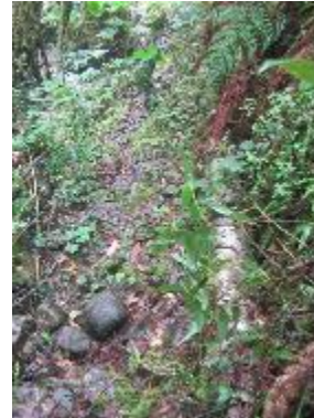
Fotografía 8. Tubería a Nivel del suelo
