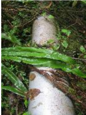
Fotografía 7. Tubería a Nivel del suelo
