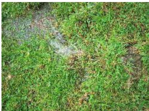
Fotografía 15. Zona de Ruptura de tubería
