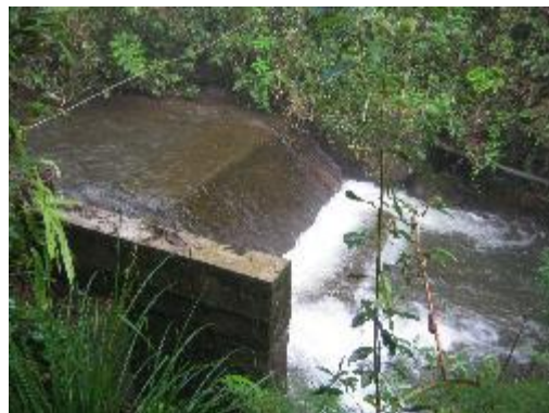
Fotografía 1. Vista Superior de la Bocatoma
