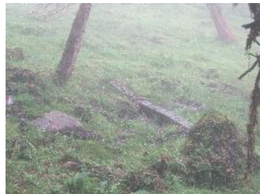
Fotografía 14. Tramo de Tubería Encofrada
