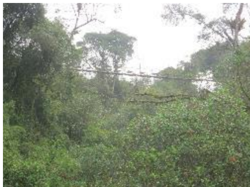
Fotografía 27. Paso Elevado # 3 tubería de PVC
