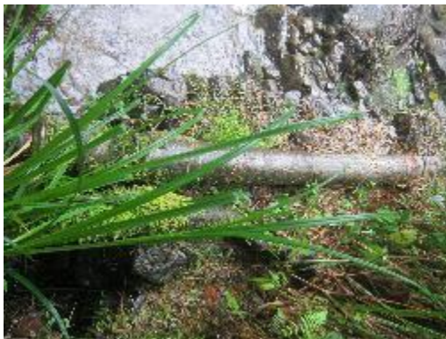
Fotografía 5. Tubería a Nivel del suelo
