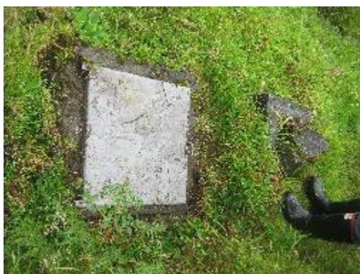
Fotografía 19. Válvula de purga
