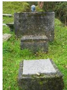
Fotografía 10. Vista Frontal del Desarenador
