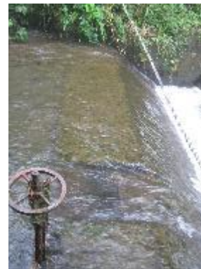
Fotografía 2. Vista Superior de la Bocatoma
