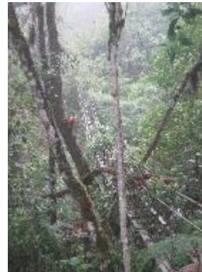
Fotografía 26. Paso Elevado # 2 tubería de PVC
