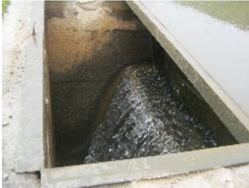
Fotografía 11. Zona de Salida del Desarenador
