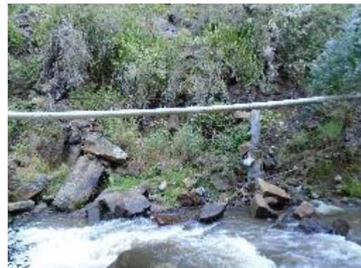
Fotografía 34. Viaducto de Tubería de PVC No 2
