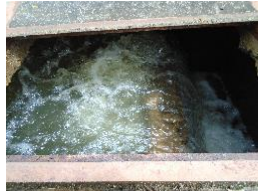
Fotografía 22. Zona de Salida Desarenador
