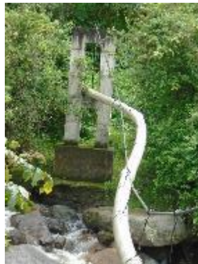
Fotografía 13. Viaducto de Tubería de PVC No 1
