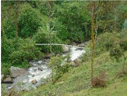
Fotografía 11. Viaducto de Tubería de PVC No 1
