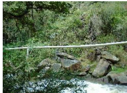
Fotografía 34. Viaducto de Tubería de PVC No 2
