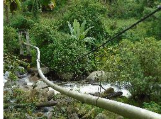
Fotografía 12. Viaducto de Tubería de PVC No 1
