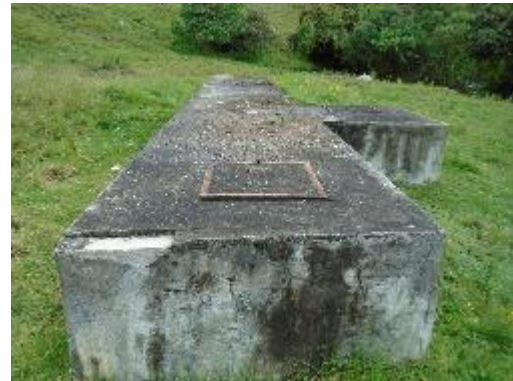
Fotografía 18. Vista Frontal de Desarenador
