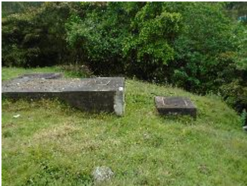
Fotografía 23. Vista Lateral Desarenador
