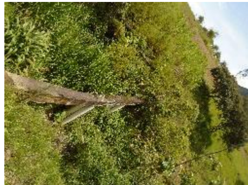
Fotografía 46. Encofrado para tubería PVC No 8
