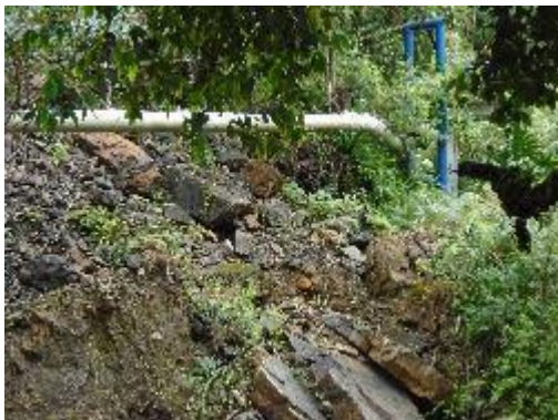
Fotografía 33. Viaducto de Tubería de PVC No 2
