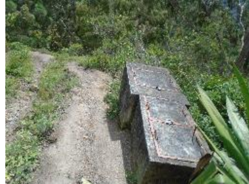
Fotografía 60. Cámara de Quiebre No 1
