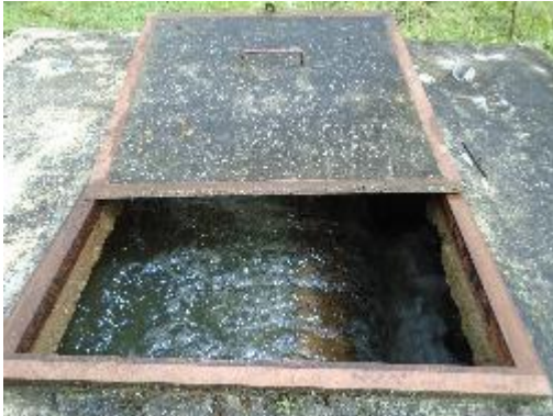
Fotografía 21. Zona de Salida Desarenador
