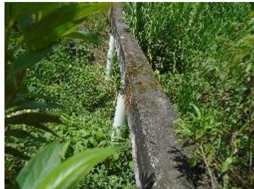
Fotografía 46. Encofrado para tubería PVC No 8
