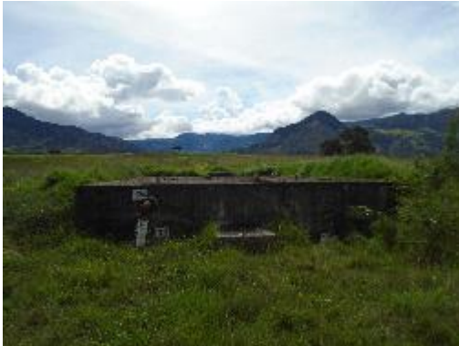
Fotografía 75. Tanque de repartición Vista Frontal
