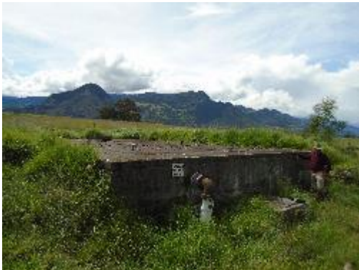
Fotografía 71. Tanque de repartición Vista Frontal
