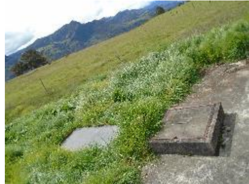
Fotografía 70. Tanque de repartición
