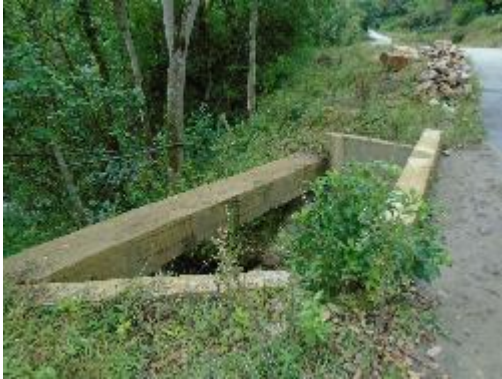
Fotografía 43. Encofrado para tubería PVC No 3
