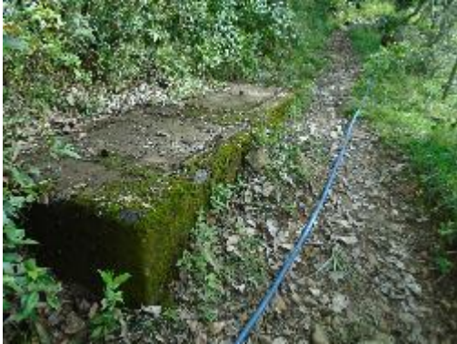
Fotografía 65. Cámara Reductora de Presión No 3
