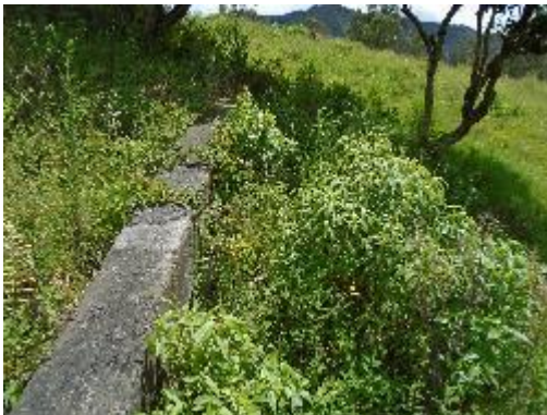
Fotografía 45. Encofrado para tubería PVC No 8
