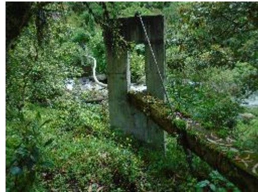
Fotografía 14. Viaducto de Tubería de PVC No 1
