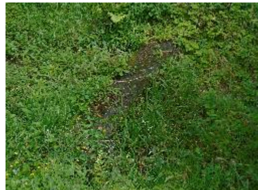
Fotografía 16. Encofrado para tubería PVC No
