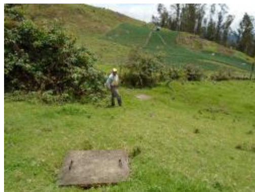
Fotografía 18. Tubería de Conducción en predios y caja de válvula de corte
