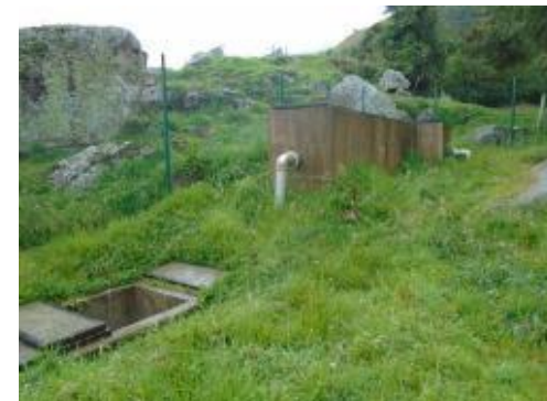
Fotografía 10. Salida Desarenador
