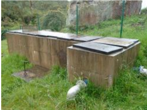
Fotografía 5. Vista lateral desarenador
