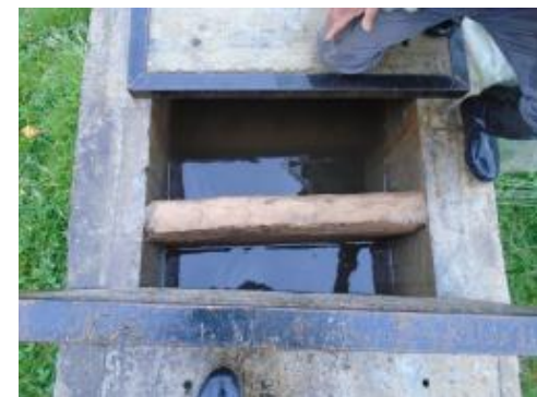
Fotografía 9. Disipador Construido por Asociación
