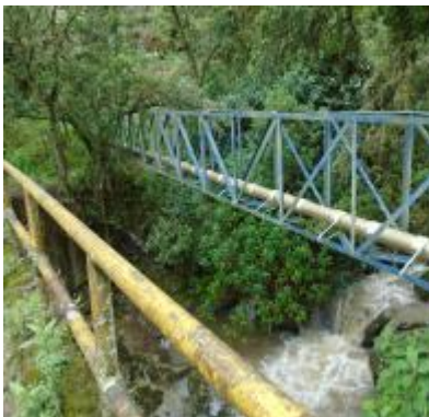
Fotografía 26. Estructural Cámara de quiebre
