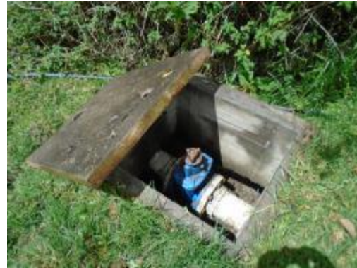
Fotografía 20. Purga de 6" N°4 conducción en falla geológica
