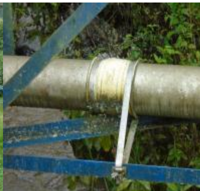
Fotografía 28. Cámara de Perdida de Presión C.Q
