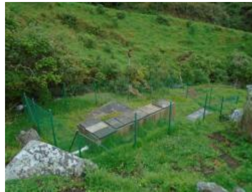
Fotografía 14. Encerramiento de Seguridad
