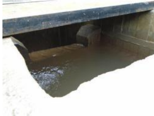
Fotografía 6. Zona de Entrada y Vertedero de Excesos
