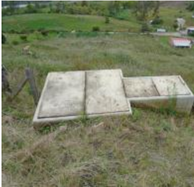
Fotografía 23. Estructural Cámara de quiebre
