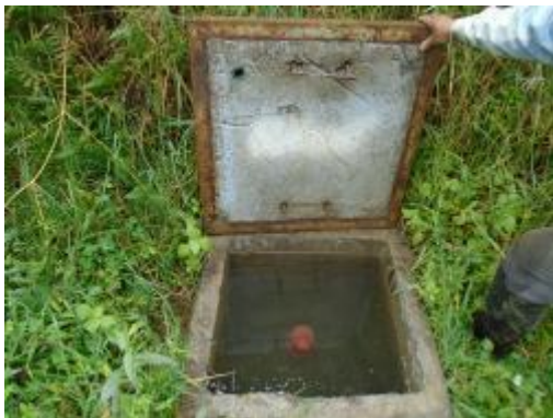
Fotografía 21. Ventosa 2" Inundada en Conducción
