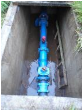
Fotografía 13. Valvulería sistema de Macromedición
