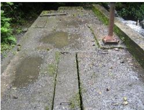
Fotografía 9. Vista Superior del Desarenador
