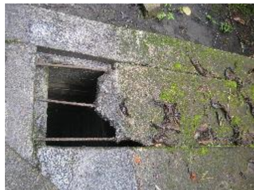
Fotografía 10. Tapas del desarenador
