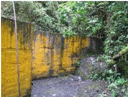
Fotografía 3. Vista Lateral de la Bocatoma
