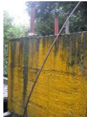
Fotografía 4. Válvulas de Control de la Bocatoma
