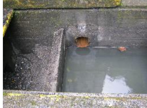
Fotografía 8. Reboce del desarenador
