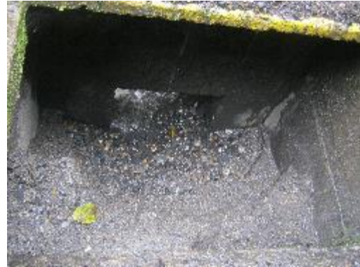
Fotografía 6. Entrada al Desarenador
