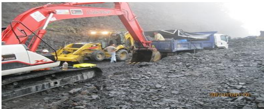
FOTOS: Retroexcavadora explotando material en el alto del quemado
