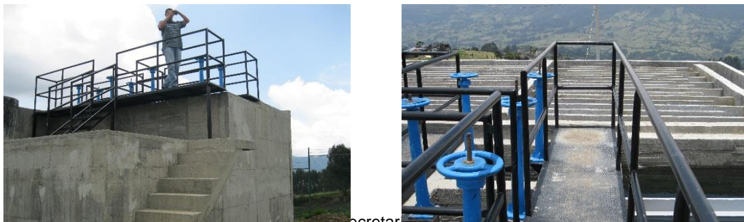
Fotos: Construcción planta de tratamiento de agua potable vereda San Jorge municipio de Zipaquirá
