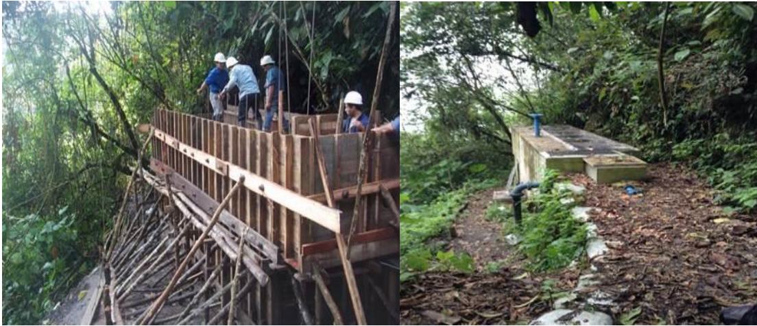
FOTOS: Rehabilitación acueducto urbano (bocatoma, desarenador, conducción) municipio de Caparrapí - Cundinamarca.
