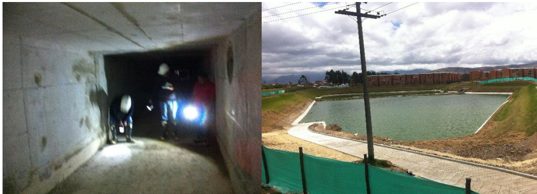
Fotos: Construcción Box Culvert alameda central y del pondaje de vivienda Ciudad Verde Soacha
