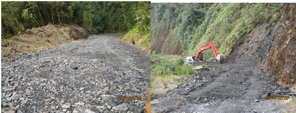
FOTOS: Conformación del material explotado del alto del quemado y remoción de derrumbes
