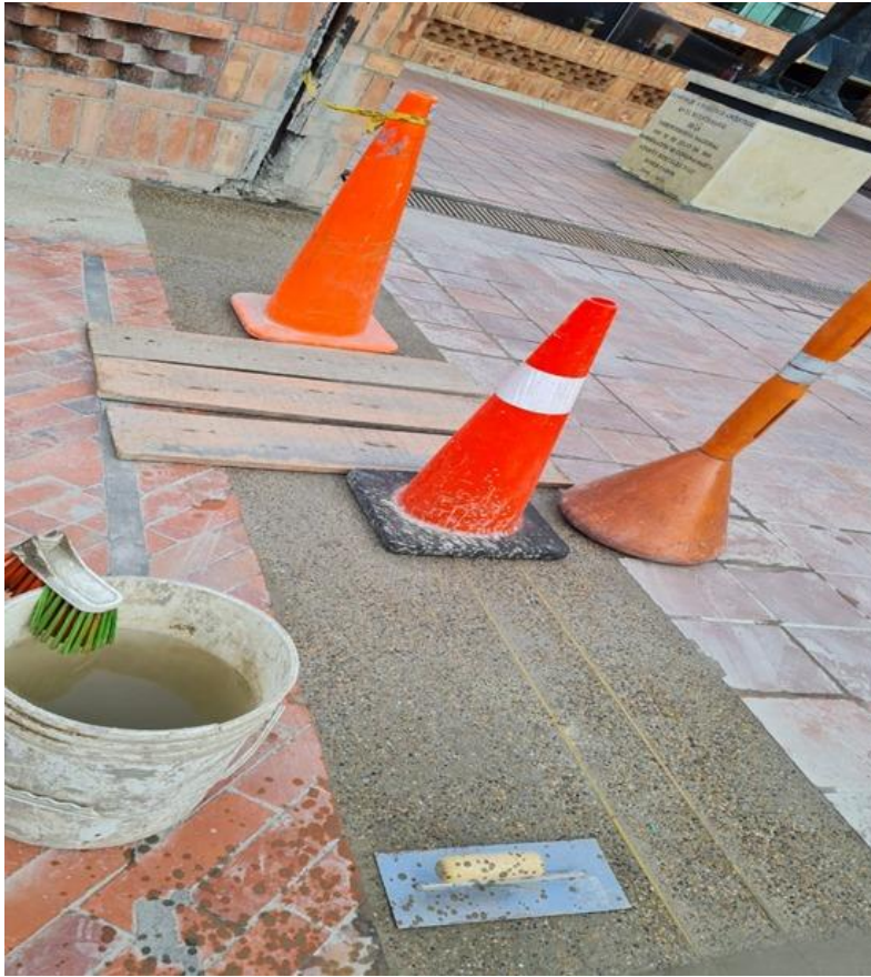
Rampa ingreso puerta 2: Demarcación para las bandas antideslizantes en rampa.
