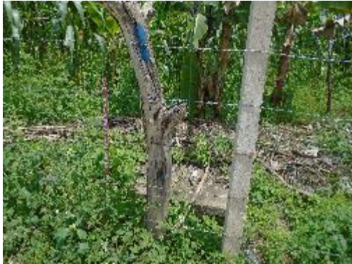
Fotografía 20. Vista Lateral Válvula de Purga.
