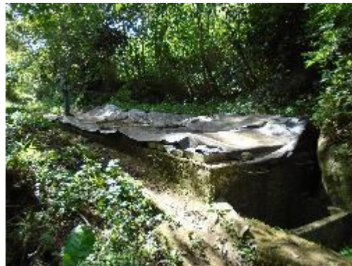
Fotografía 10. Desarenador.
