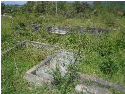
Fotografía 24. Planta de Tratamiento.
