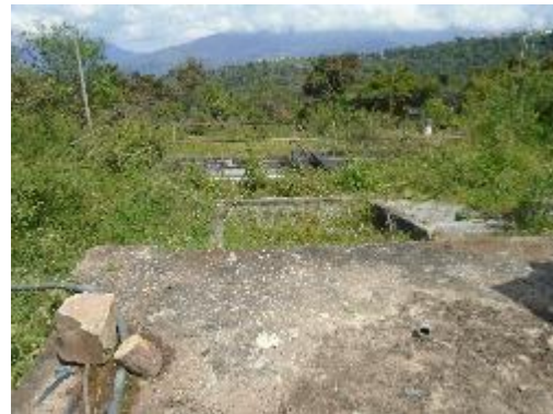
Fotografía 25. Planta de Tratamiento.
