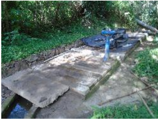
Fotografía 7. Desarenador.
