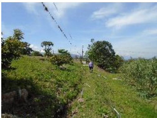
Fotografía 15. Tramo de la Conducción.
